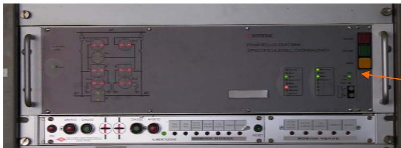
DV966 Gestore stato del neutro - Il dispositivo assicura, tramite i suoi automatismi, la corretta predisposizione degli IMS relativi allo schema di inserzione delle bobine di compensazione. La predisposizione degli organi di manovra viene effettuata in funzione dello stato degli interruttori MT dei trasformatori AT/MT (TrR e TrV) e dello stato del congiuntore di semisbarre K.
