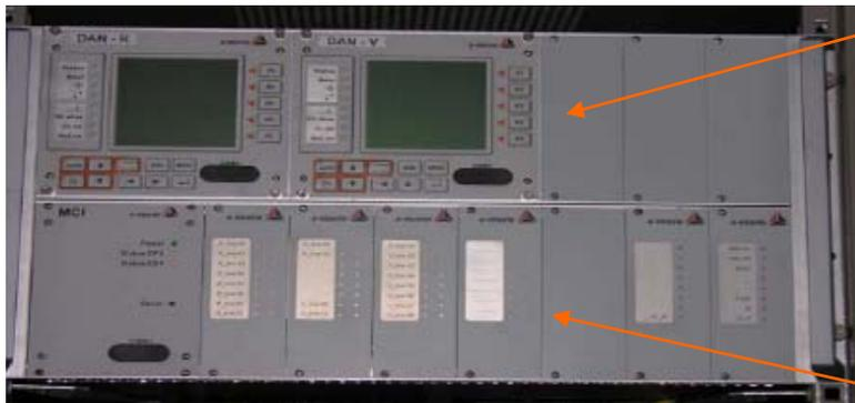
DV927 Dispositivo Analizzatore di Neutro - **Regola in modo automatico e continuo** il grado di accordo tra la bobina mobile e la capacità omopolare della rete MT cui è collegata.
